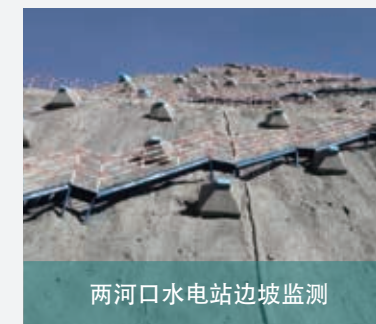
两河口水电站边坡监测（边坡锚索测力监测）
